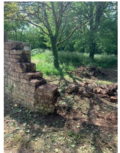
Aînénuhars – Démolition d'un mur – Ville de Melle
